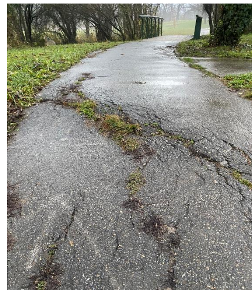
Réfection de cheminements déformés parc du Bruchet
